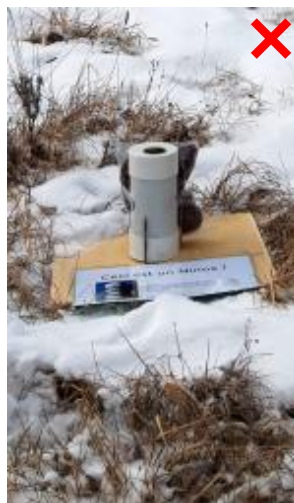
Système Ninox trop près du sol avec un risque que l'humidité pénètre dans le boîtier
